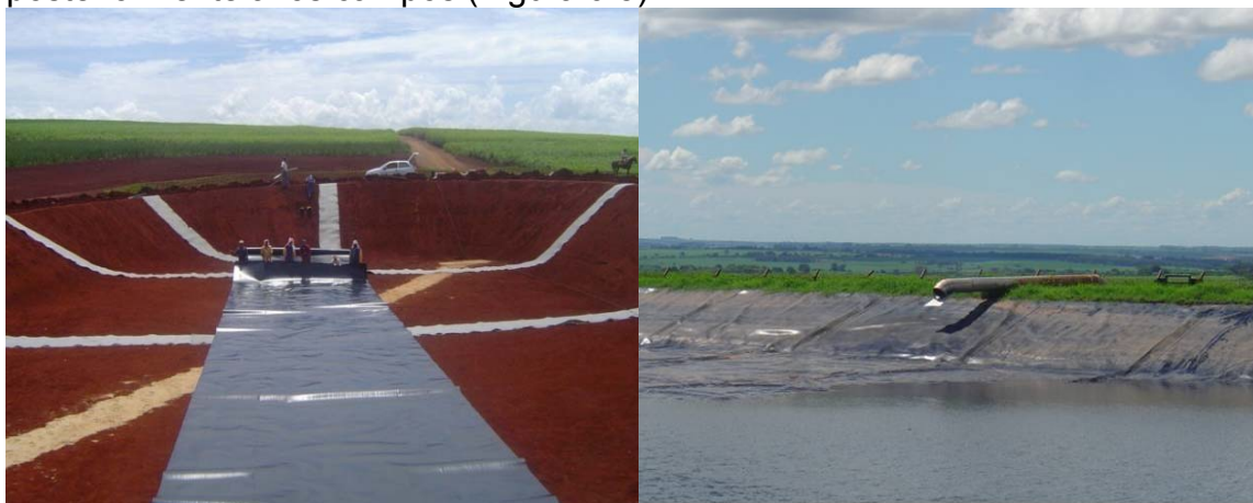
Figura 9.5. Embalse impermeabilizado para la recepción de la vinaza en Brasil (Grupo de técnicos de PDVSA-AGRÍCOLA, 2008).
