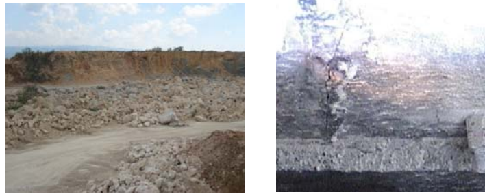
Fig. 1 Vista de las piedras en la cantera y de una grieta en los laterales de la criba
