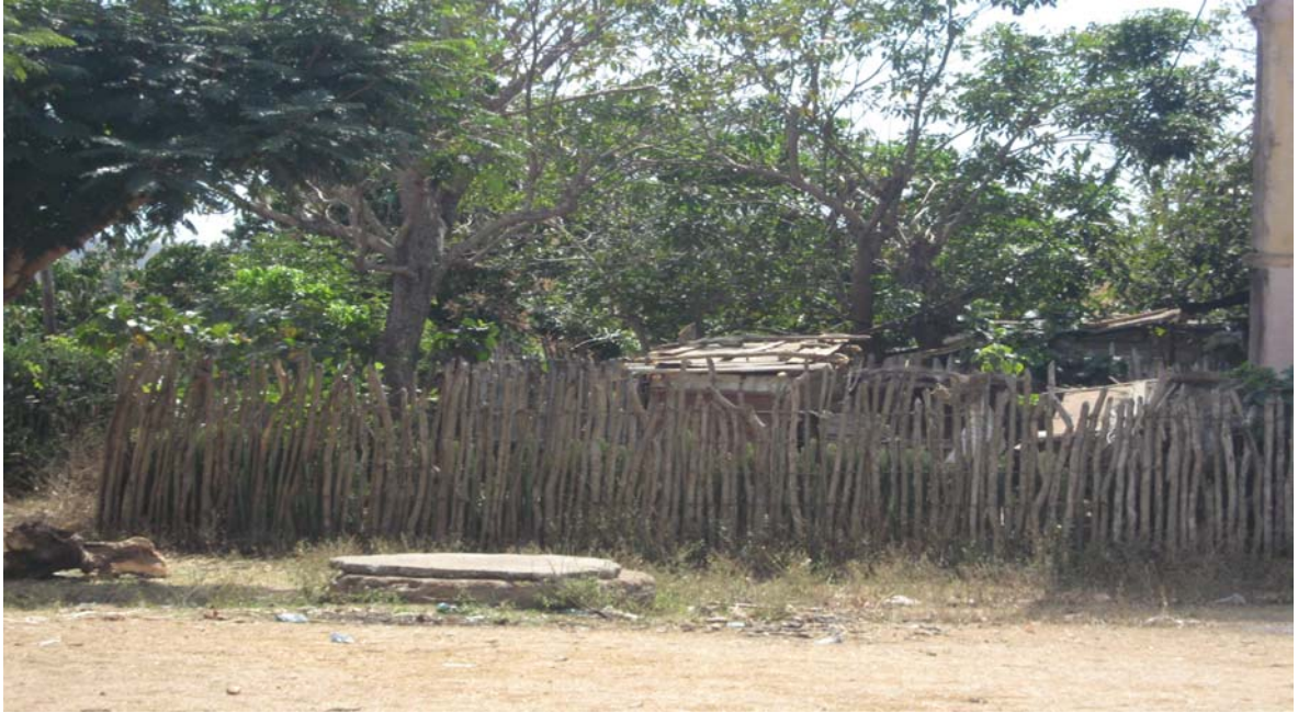
Corrales detrás de los edificios con falta de higiene.
