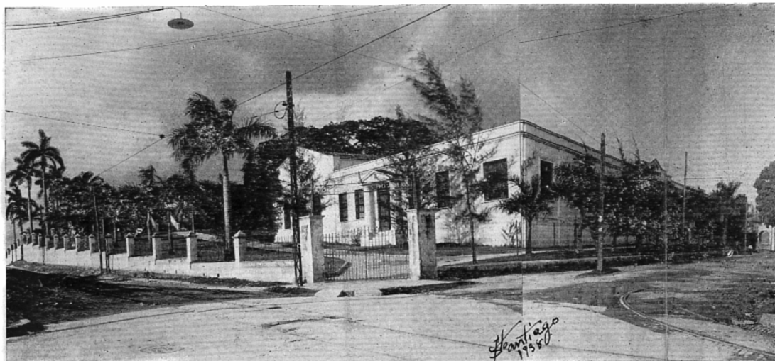
VISTA GENERAL DEL COLEGIO
