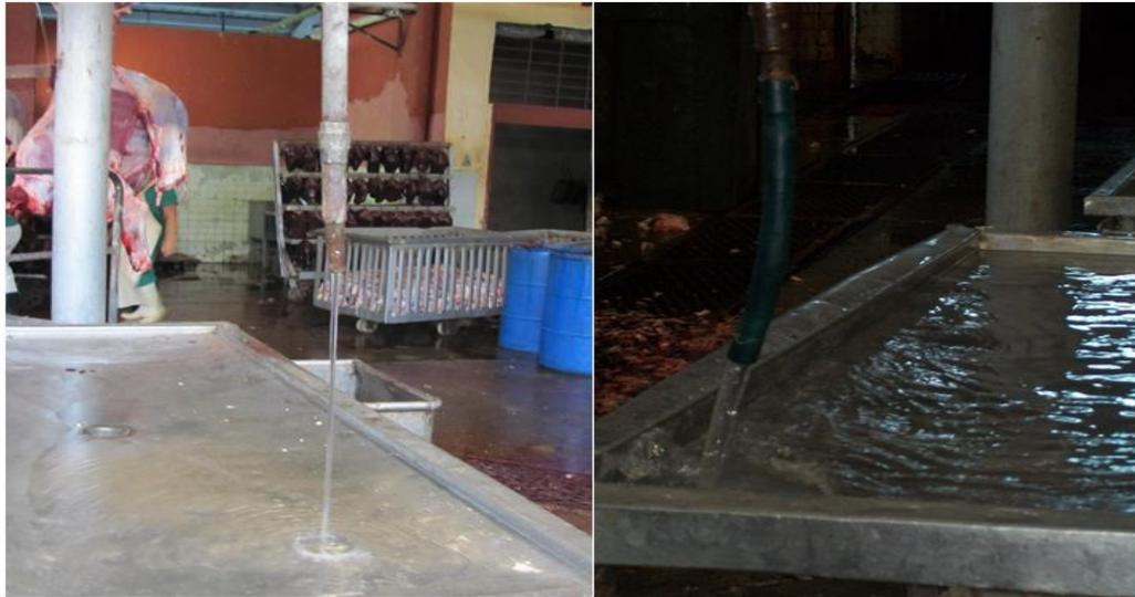
Figura 2.7: Mangueras sin dispositivos de cierre en la ECC.
