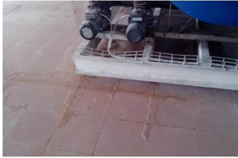
Figura 3.19 Salideros y fugas de aguas.
