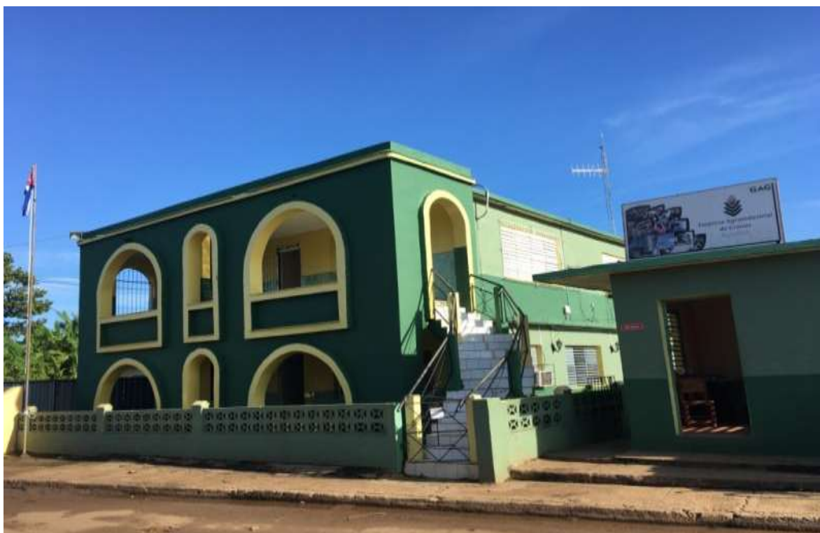
Anexo # 3 Fachada de la EAIG Aguada
