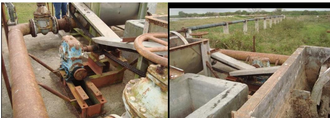
Figura 2.3 Sistema de bombeo de residuales líquidos.
