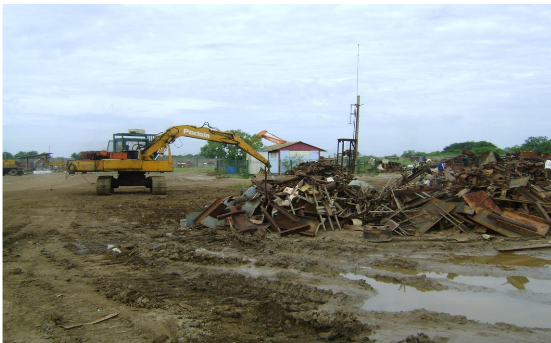
Fig. 2.11- Almacén a cielo abierto de la chatarra ferrosa.
