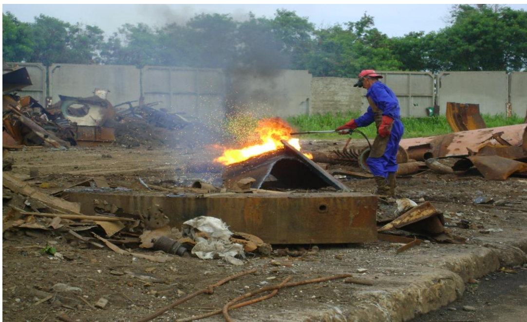
Fig. 2.10- Procesamiento de la chatarra de acero mediante oxicorte.
