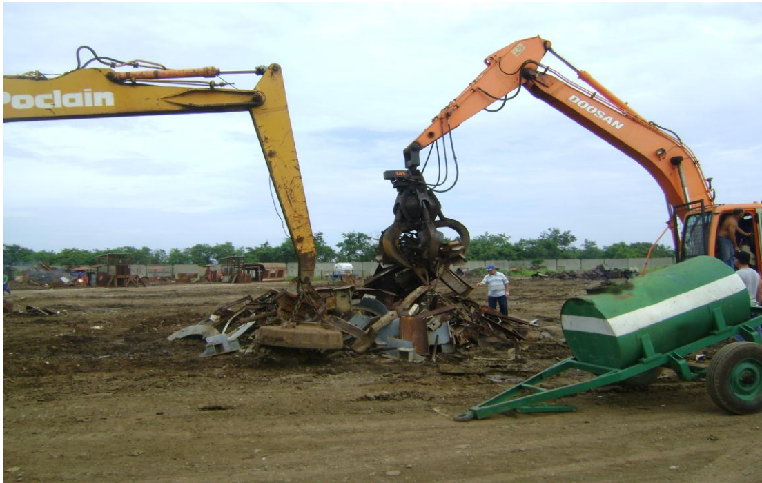
Fig. 2.9 - Descontaminación de la chatarra ferrosa mediante grúas.
