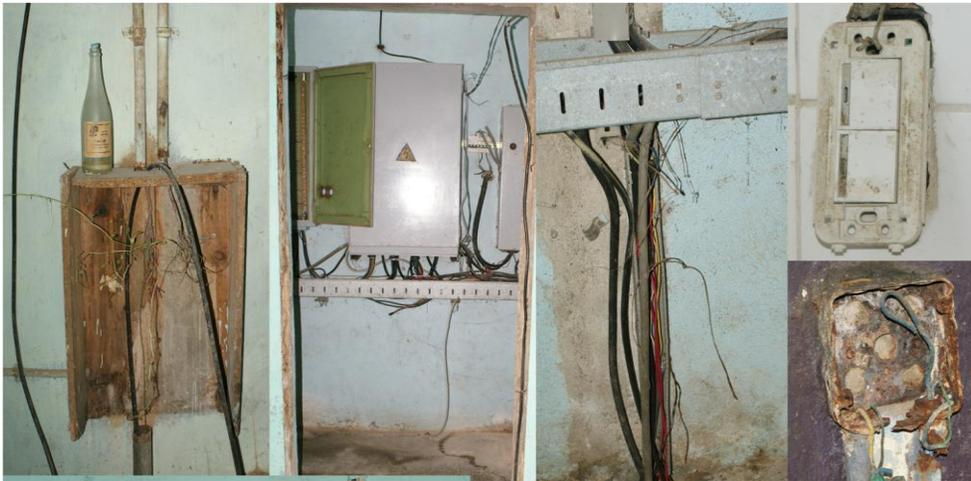
Fig. 1. Ejemplos de deterioro en la red de distribución de energía eléctrica.
