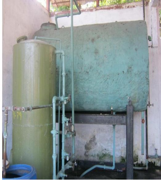
**Figura 31 Tanque de tratamiento de agua alimentar**
