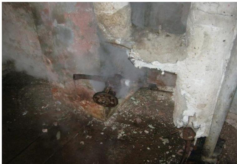
**Figura 34 Deficiente protección de los conductos.**
