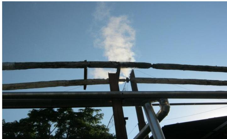
**Figura 33 Fuga en la tubería principal.**
