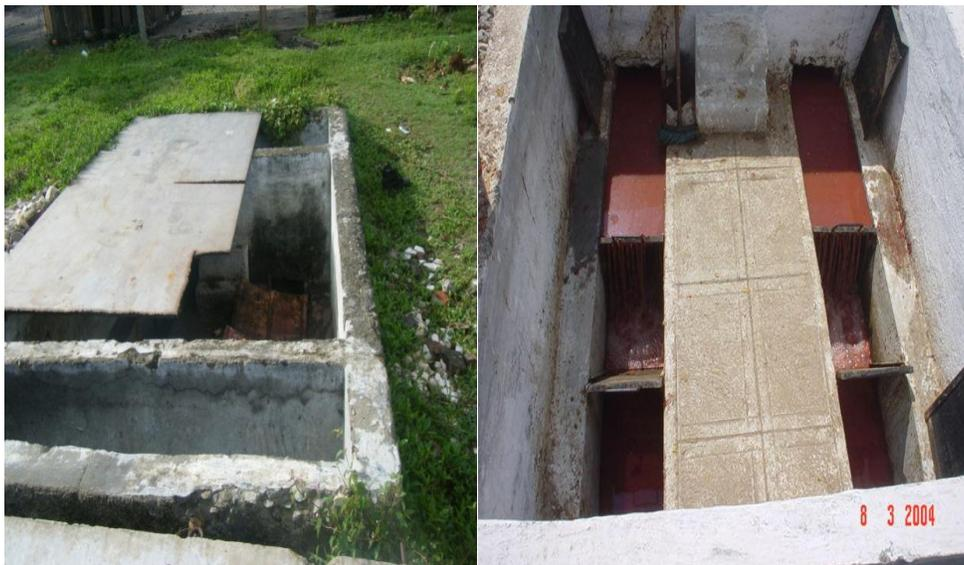
**Figura 37 Trampa de rejas de para retención de sólidos en mal estado.**
