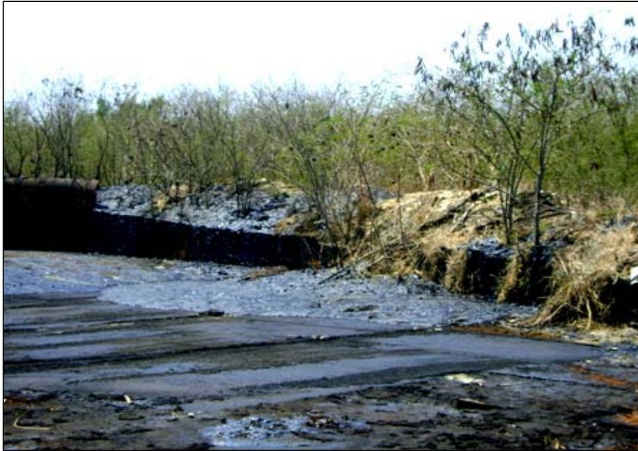
Fig.1 Fondo de tanque con derrame de hidrocarburo. Nótese la ausencia de paredes a causa del vandalismo. Foto Cortesía Unidad de Supervisión CITMA.
