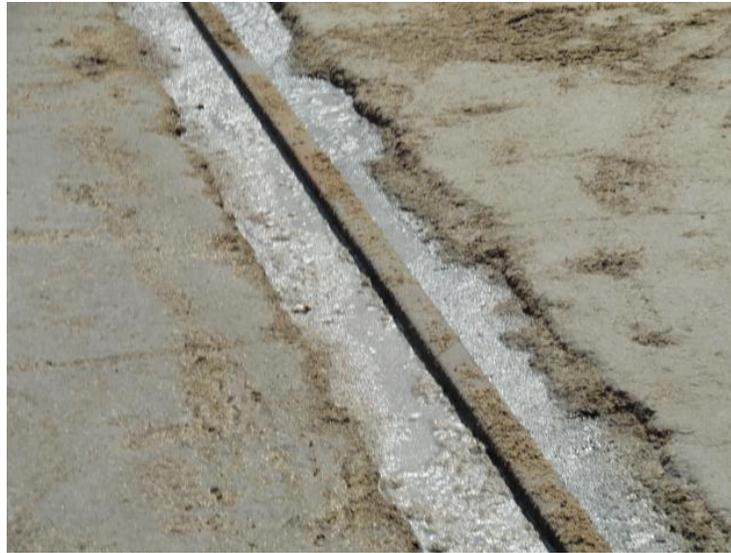
Figura No 10. Residuos de carga descompuestos en las vías de las grúas de pórtico
