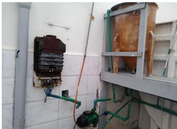
**Figura 2.11-** Calefón de Cría Larvas en Centro de Producción de UEB YAGUACAM. Fuente: Elaboración propia
