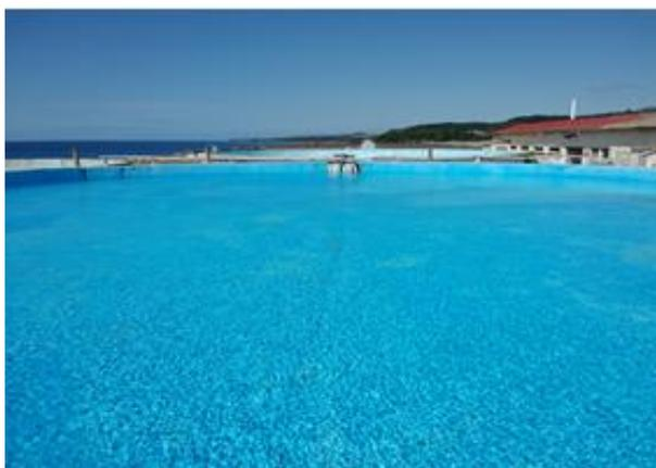
**Figura 2.13-** Sedimentadores de agua salada en Centro de Producción de UEB YAGUACAM. Fuente: Elaboración propia
