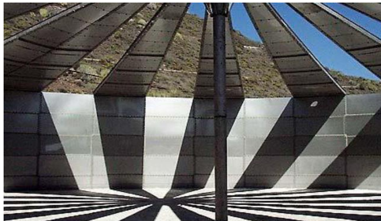
Figura 2.6 Cubierta de tipo cónica de un biodigestor
