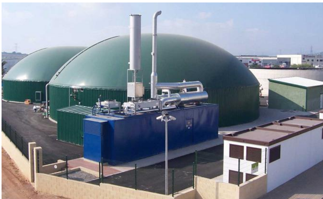
Figura2.4 modelo de un biodigestor industrial.
