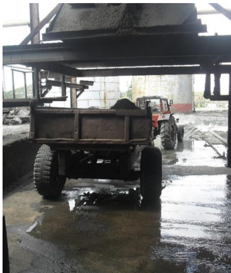
Figura 3.3 Vista de la instalación para extracción de la cachaza mediante carretas
