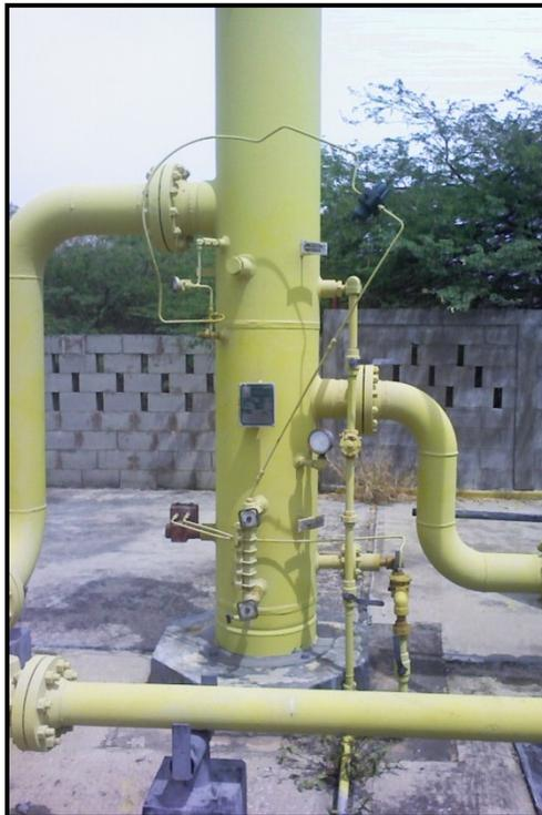
Figura 62. Regulador del interruptor de presión. No se encuentra fijo al sistema. Fuente: Rincón, (2011).
