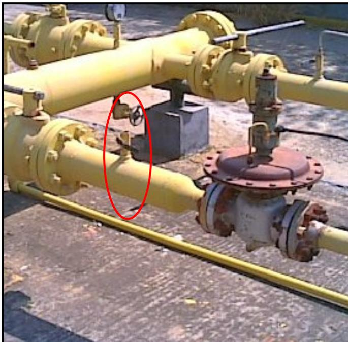
Figura 58. Ausencia de instrumento de medición. Fuente: Rincón, (2011).
