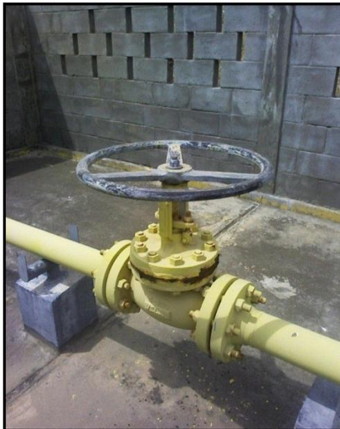
Figura 54. Válvula de compuerta instalada en la estación. Fuente: Rincón, (2011).
