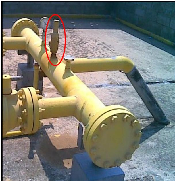
Figura 52. Válvula de seguridad. La válvula de seguridad en la salida de la estación no está conectada a la línea de venteo. Fuente: Rincón, (2011).
