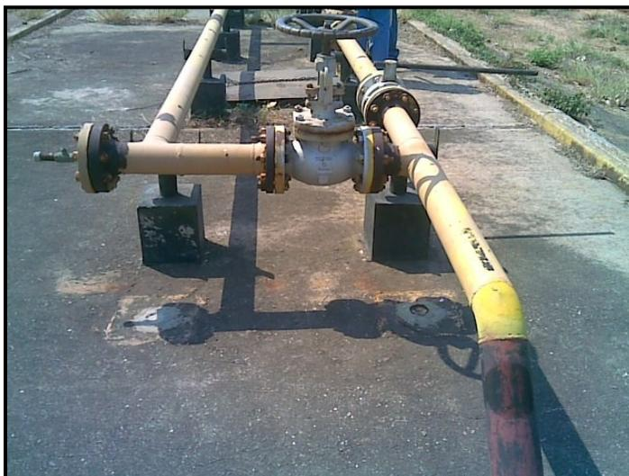
Figura 64. Válvula de compuerta. Instaladas para el paso del gas son de compuerta, deben ser de bola. Fuente: Rincón, (2011).
