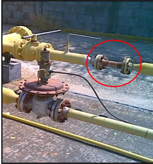
Figura 47. Regulador de presión. Debería estar instalado en la línea de gas secundaria. Fuente: Rincón, (2011).
