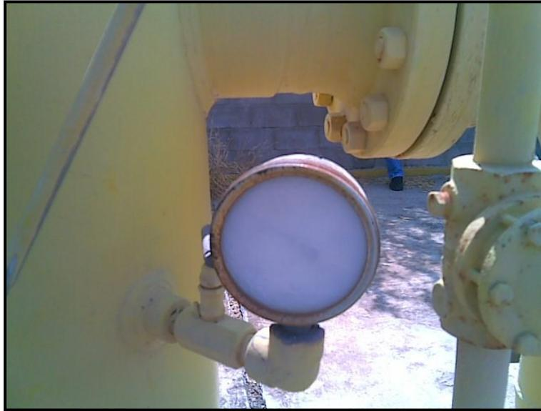
Figura 57. Manómetro del separador con dificultades para visualizar medidas. Fuente: Rincón, (2011).
