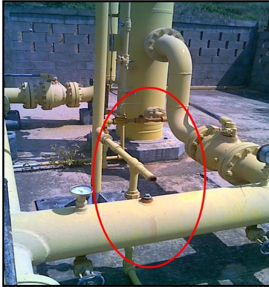
Figura 51. Sistema de alivio. La tubería de alivio de venteo no está conectada al sistema de gas principal.
