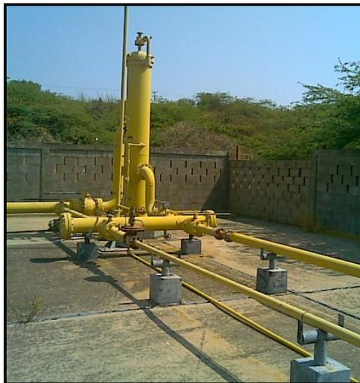
**Figura 50. El separador no tiene instalado una válvula de seguridad. Fuente: Rincón, (2011).**
