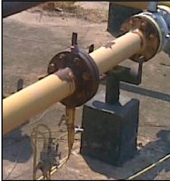
Figura 65. Bridas de la estación. Algunas bridas presentan falta de espárragos y tuercas. Fuente: Rincón, (2011).
