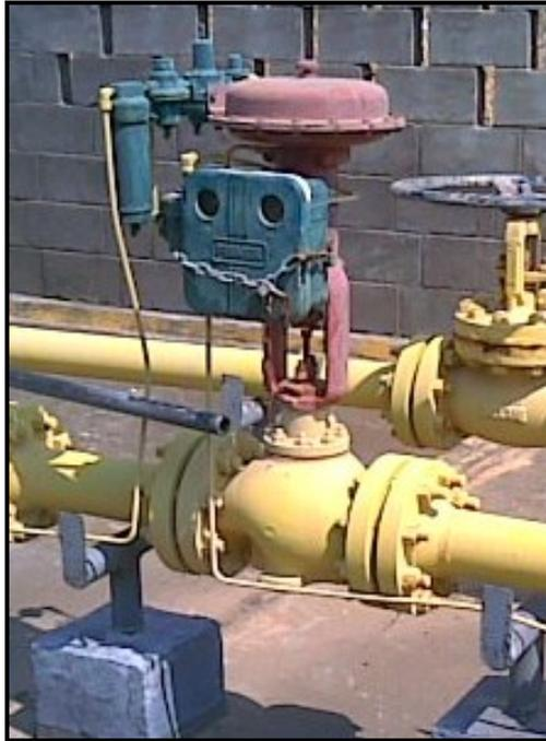
Figura 59. Válvula de control. Instalada en la entrada de la estación presenta falta de calibración. Fuente: Rincón, (2011).
