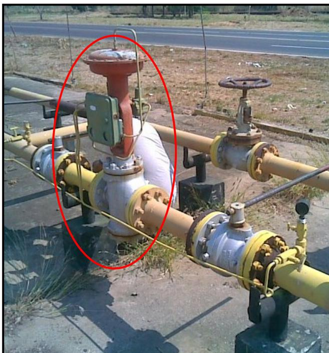
Figura 67. Válvula de control. Fuente: Rincón, (2011).
