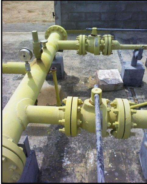
Figura 53. Válvulas de bola de la estación. Fuente: Rincón, (2011).
