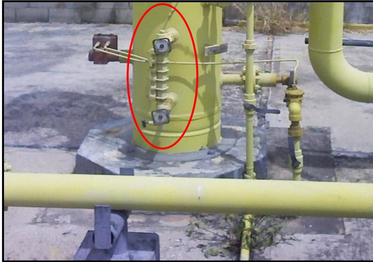
Figura 61. Trampa de condensado del separador. La válvula de drenaje de condensado del separador no se pudo operar. Fuente: Rincón, (2011).
