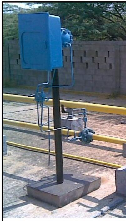
Figura 48. Medidor de flujo y presión “registrador”. Fuente: Rincón, (2011).
