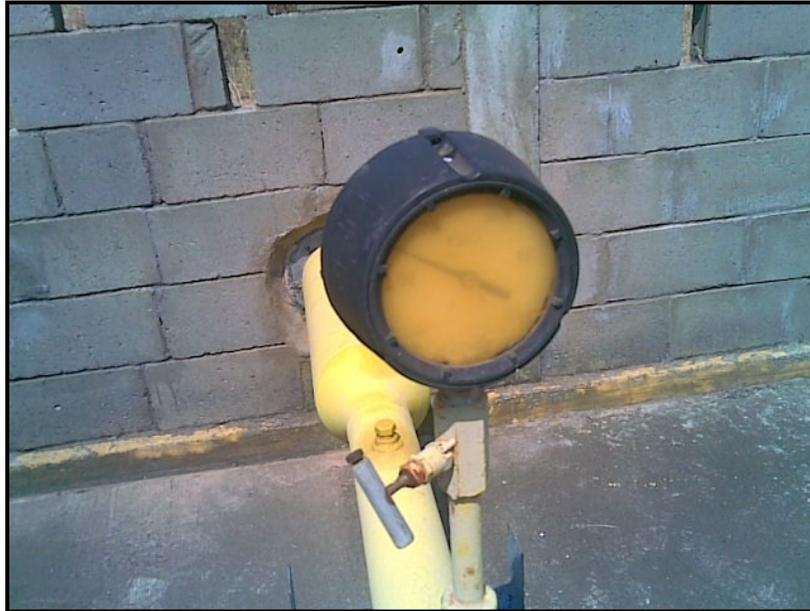
Figura 55. Manómetro. Ubicado en la entrada de la estación presenta signos de falta de mantenimiento.
