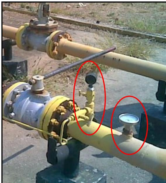
Figura 66. Instrumentos de medición de temperatura y presión. Presentan falta de mantenimiento. Fuente: Rincón, (2011).
