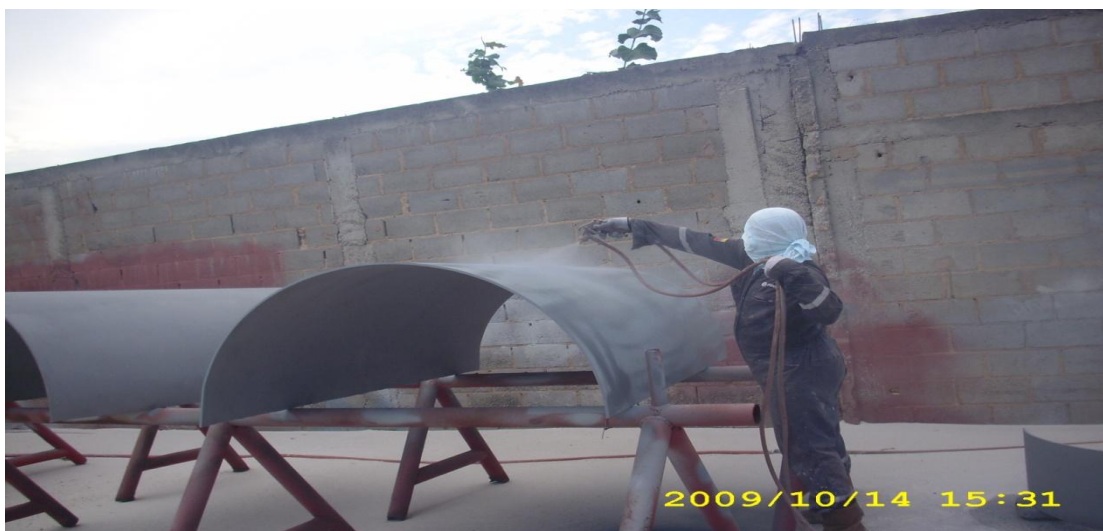
Fig.2.7. Muestra Foto de un componente tubular al realizarle el sandblasting
