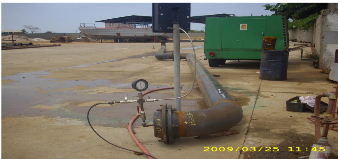
Fig. 2.10. Foto que muestra el prefabricado tubular, con montaje de prueba Hidrostática.
