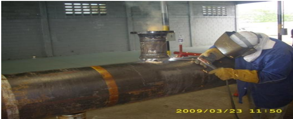
Fig. 2.6. Foto muestra proceso de soldadura de un tubular
