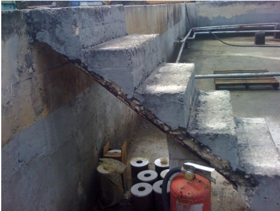
Anexo A-Norte Andros muro de contención de combustible.
