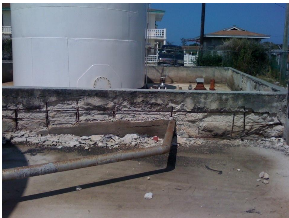
Anexo A -Central Andros muro de contención de combustible
