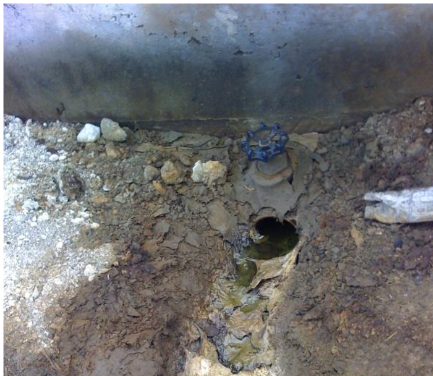
Anexo A-Norte Andros muro de contención de combustible
