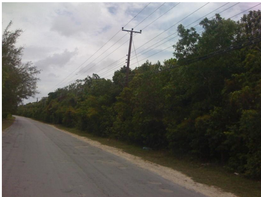
Anexo B -Central Andros líneas de transmisión eléctrica
