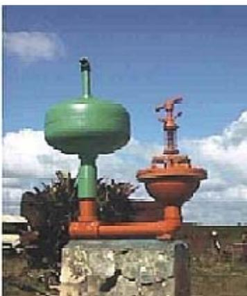
El ARIETE HIDRAULICO es una bomba de chorro de agua que actúa por choque. Este levanta agua empleando la fuerza que se genera cuando una masa de agua en movimiento se detiene repentinamente. A este fenómeno se le da el nombre de golpe de ariete y se produce por la transformación de energía cinética a energía de presión. Lo que se hace con el ariete es llevar una parte de un caudal grande de agua con poca caída a una cota mayor.
