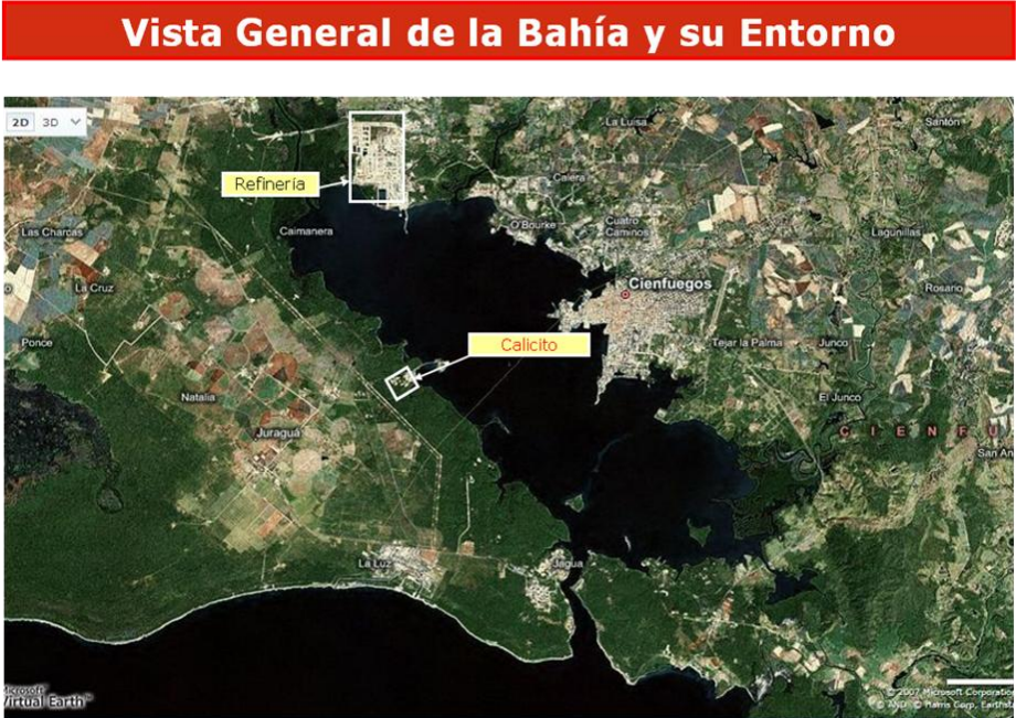
Figura No 2.4. Complejo Petroquímico en Calicito, ubicación en la Bahía de Cienfuegos.
