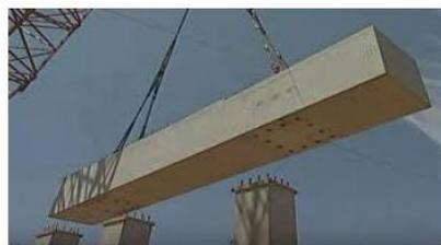
Elementos prefabricados estructurales
