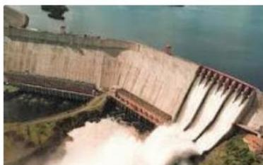
**HORMIGÓN EN MASA:** Muro de represa.
