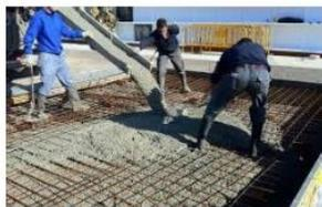
Hormigón armado con resistencia a la compresión a los 28 días hasta 20 MPa
