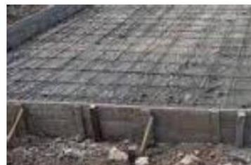
**Cimentaciones:** conjunto de elementos estructurales, cuya misión es transmitir sus cargas o elementos apoyados en ella al suelo, distribuyéndolas de forma que no superen su presión admisible ni produzcan cargas zonales).
