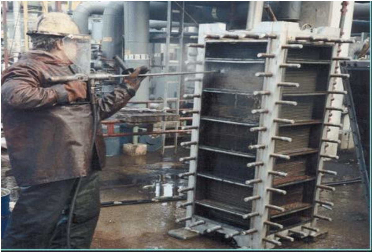
Anexo 14. Limpieza mecánica. Fuente. (Moncada, 2006).
