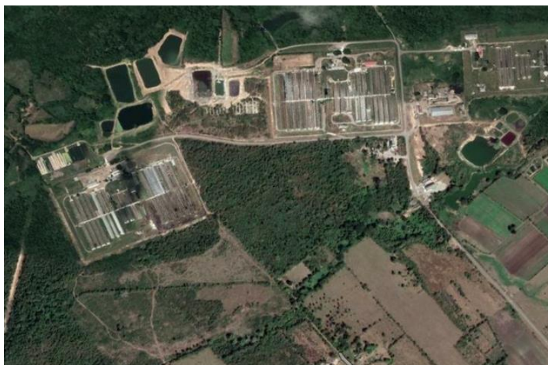
Figura 2.1. Vista aérea de la Empresa Porcina de Cienfuegos. Fuente. Elaboración propia.
