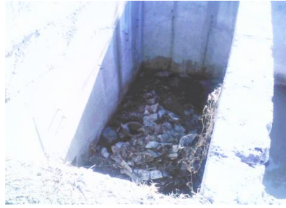
Figura 3.8. Imagen del tanque séptico actual. Fuente. Informe ambiental del CITMA.
