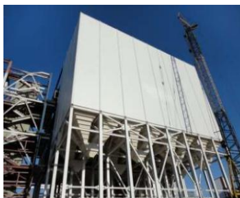
Figura 15. Silos con fondo cónico. Fuente: (Crisci, 2017).
