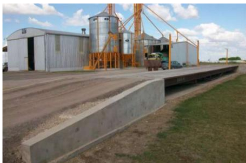
Figura 7. Báscula camionera o de plataforma. Fuente: (Crisci, 2017).
