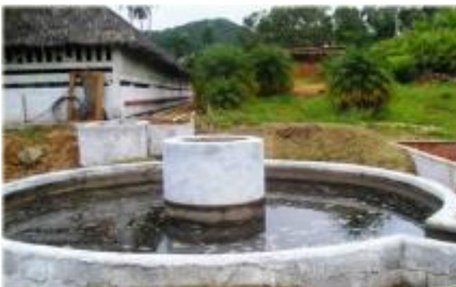
**Fig. 3 Digestor de cúpula fija**
