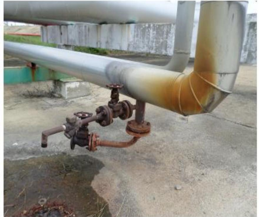
**Anexo # 4. C** Imágenes de corrosión en trampas, válvulas y líneas de vapor provocados por los valores ácidos de los mismos.
