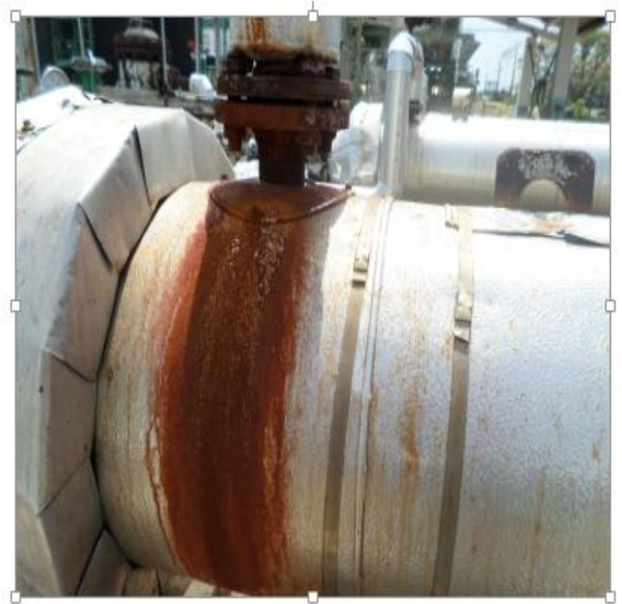
**Anexo # 4. B** Imágenes de corrosión en trampas, válvulas y líneas de vapor provocados por los valores ácidos de los mismos.
