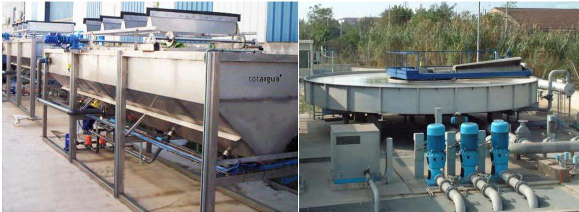
**Figura 4.** Tipos de flotadores por aire disuelto.
