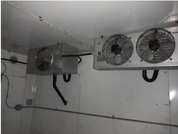
Figura 2.8 de un Evaporadores de la cámara de refrigeración UCF
