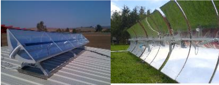
Figura 1.13. Calentadores solares por concentración. Imagen extraída de Google.
