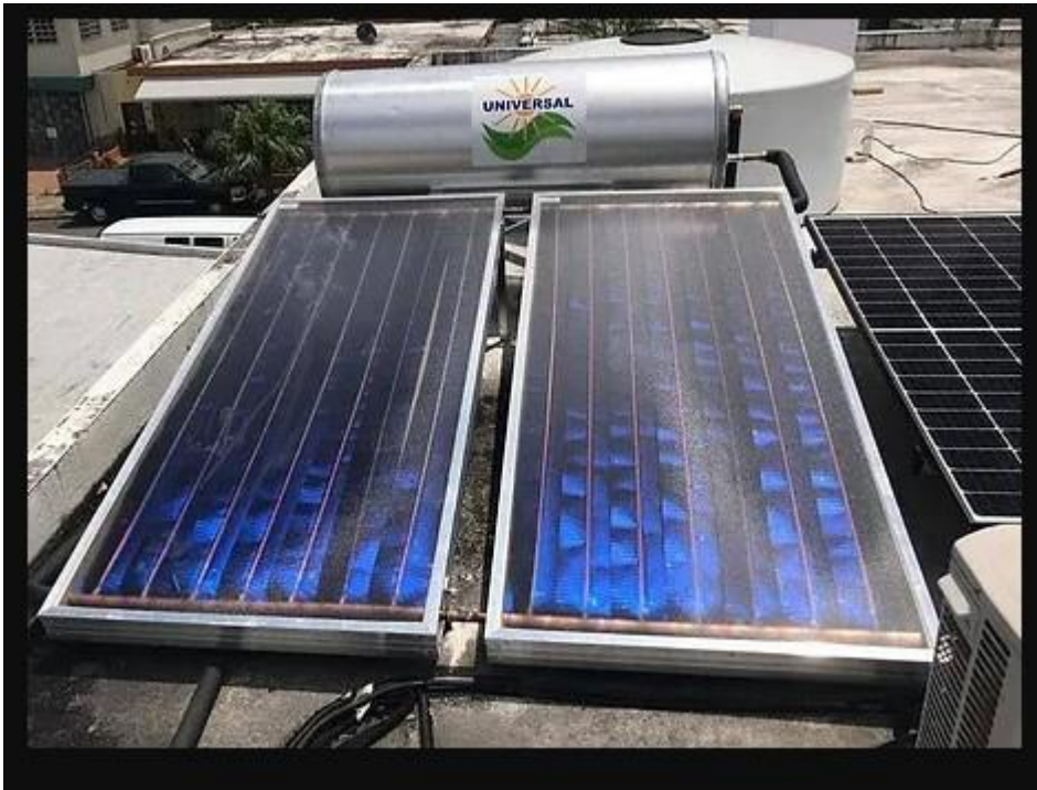
Figura 1.11. Modelo de calentador solar de placa plana. Imagen extraída de Google
