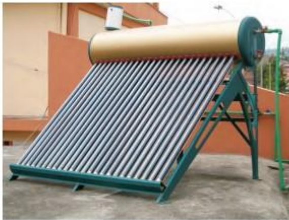
Figura 1.10. Calentador solar de tubos al vacío. Imagen extraída de Google.
