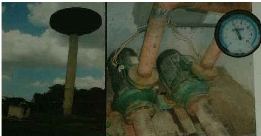
Figura 2.1 Vista de la instalación existe. (Elaboración propia)
