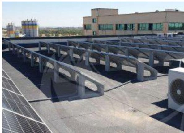
Figura 1.2 Integración en techo plano. Fuente: (Cambio Energetico , 2021)
