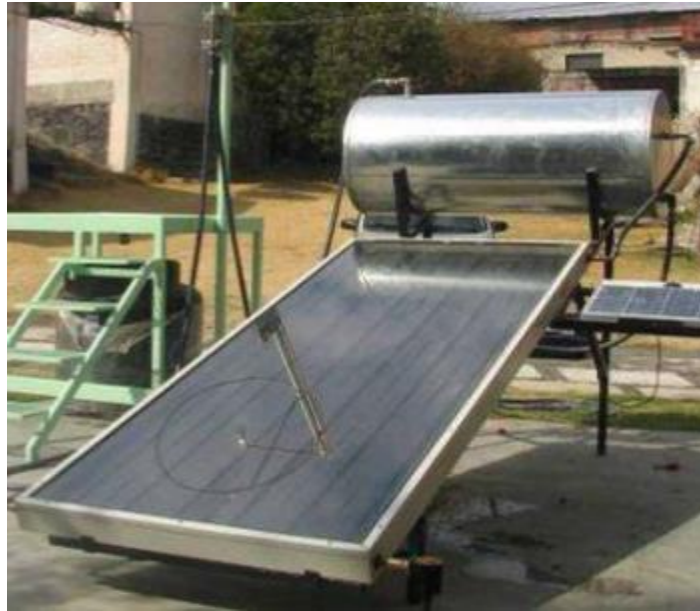
Figura 1.13. Modelo de calentador solar de placa plana. Imagen extraída de (Ravi et al., 2020).
