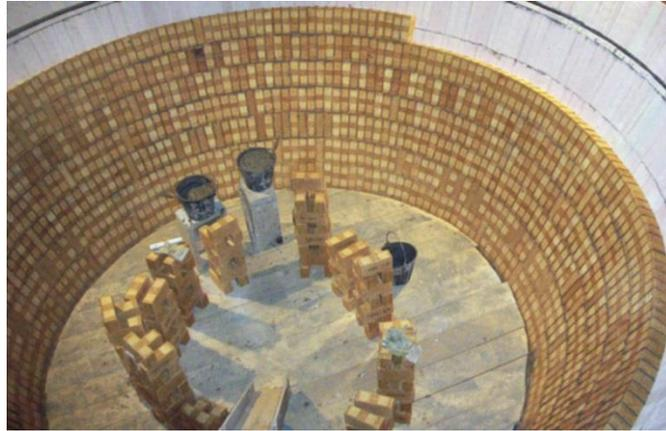
Fig. 2.8 Disposición del refractario en el interior del ciclón.
