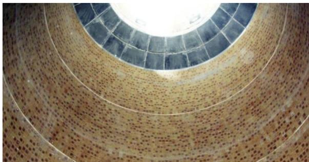
Fig. 2,10 Disposición interior del refractario.
