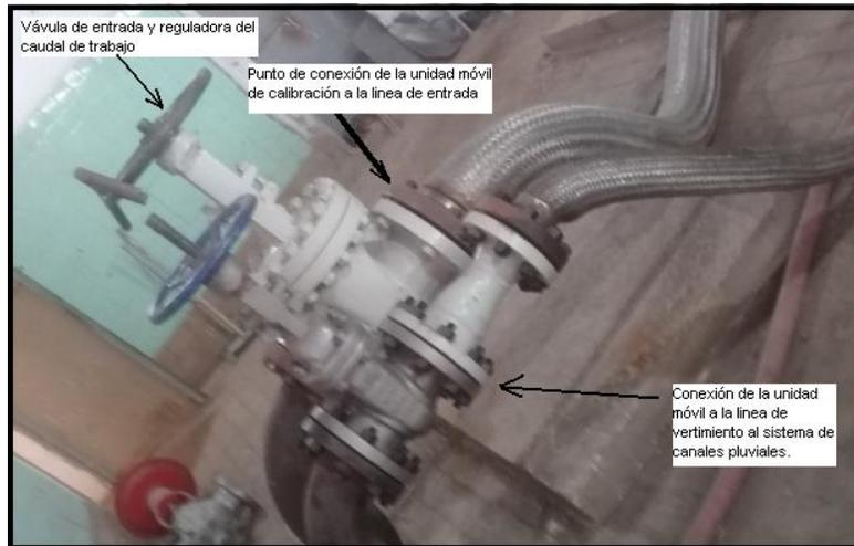
**Figura 2.2 Conexión de la unidad móvil a la línea de entrada.**
