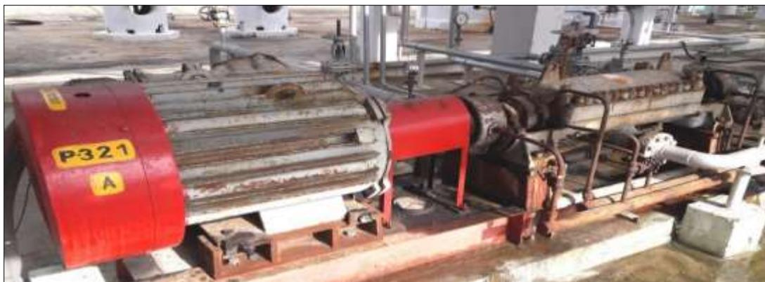
Figura 2.1. Bomba centrífuga multietápica modelo: НПС 65/35-500 -1B-COP
