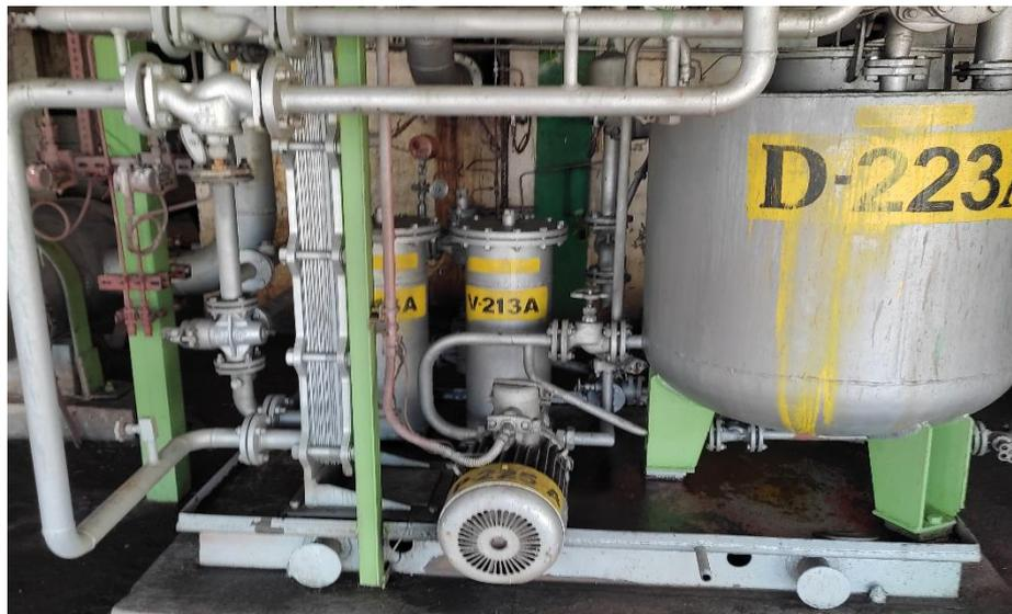
Figura 2.3 Depósito de aceite, motor, filtro e intercambiador de placas.
