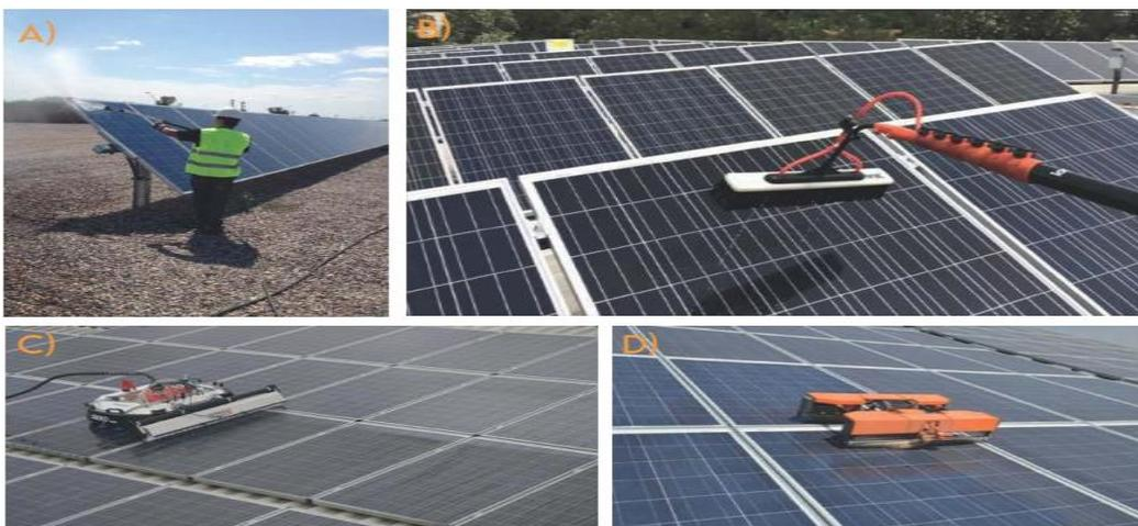
**Figura 1.21:** Clasificación de los distintos métodos de limpieza.
