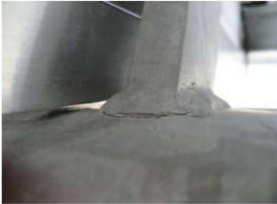
**Figura 1.19:** Daño por rotura en la fijación del sistema. **Fuente:** (Tsoutso, 2011)
