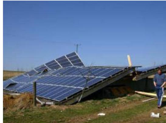
**Figura 1.20:** Módulos dañados por una tormenta. **Fuente:** (Tsoutso, 2011)
