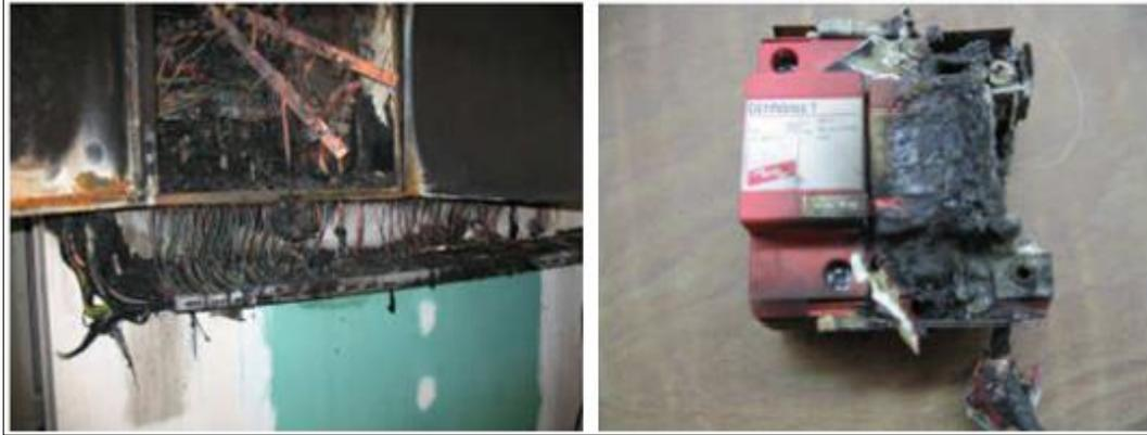
**Figura 1.18:** Cortocircuito y sobretensión en el Inversor. **Fuente:** (Tsoutso, 2011)
