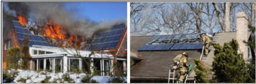
**Figura 1.16:** Instalación Fotovoltaica sobre cubierta durante y después del incendio. **Fuente:** (Tsoutso, 2011)
