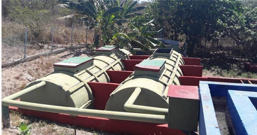
Figura 2.6 Foto. Los dos tanques axilares y el tanque donde ocurre la decantación. Fuente: (Información obtenida en la Intitucion, 2020)
