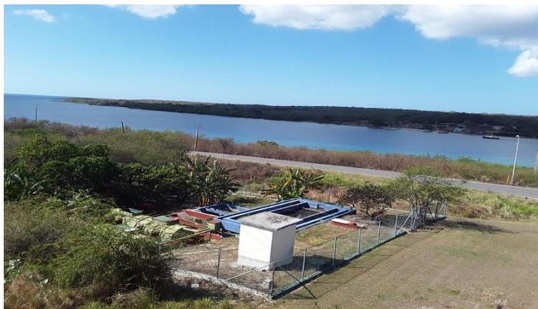
**Figura 2.4 Foto del área de almacenaje de las aguas albañales, tanque Imhoff en azul. Fuente: (Información obtenida en la Intitucion, 2020)**
