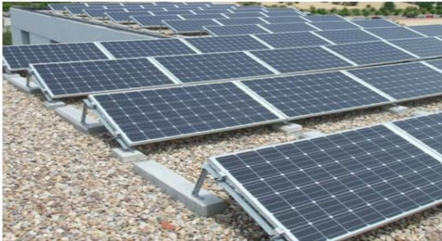
**Figura 1.5:** Sistema de fijación en cubierta plana de módulos fotovoltaico. **Fuente:** (López, 2018)
