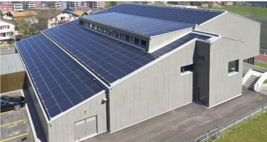
**Figura 1.4:** Integración de fotovoltaicos en cubiertas inclinada. **Fuente:** (López, 2018)
