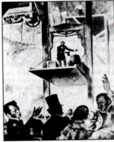
Figura 1.4 Primer ascensor para personas en el Palacio de Cristal de Nueva York.
