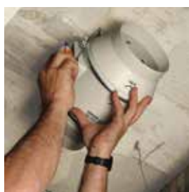
Colocar el cuerpo motor.
