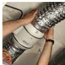
Acoplar los conductos.
