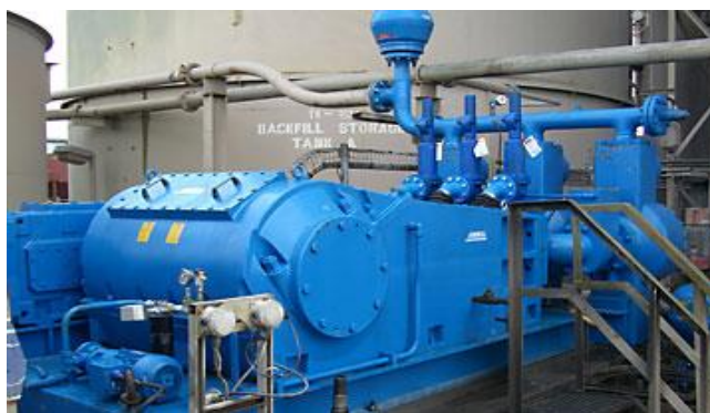
Figura 1.11: Rango de operación: hasta 600 m 3 /h (2640 GPM) y 25,0 MPa (3625 psi). Fuente: (Pérez, 2012)
