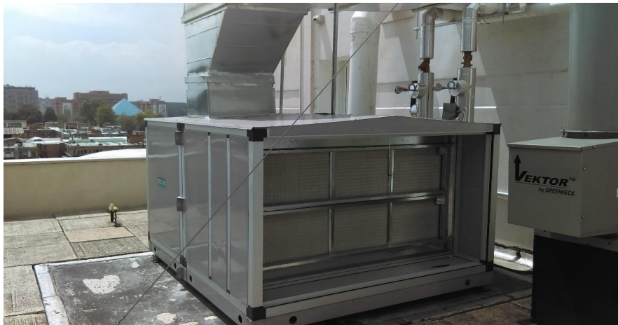
Figura 6. Unidad manejadora de aire (UMA) (Pérez, 2009)
