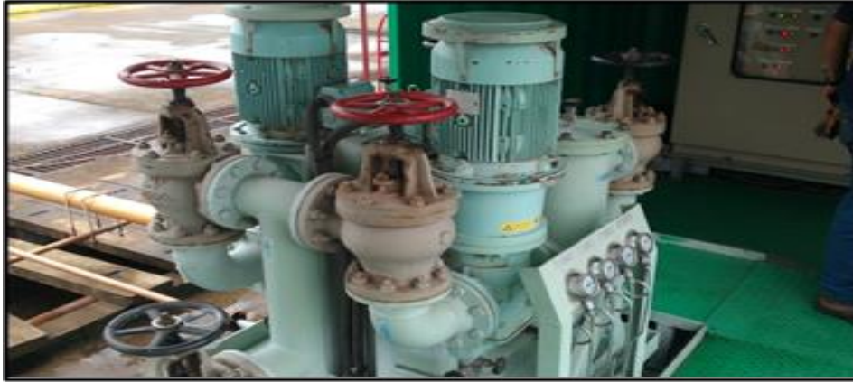
Figura 1.5 Bomba de Recepción de Diesel. Tipo: Tornillo, Q: 25 m 3 /H, P: 3,5 bar Fuente: Central Eléctrica Fuel-Oil Yaguaramas.
