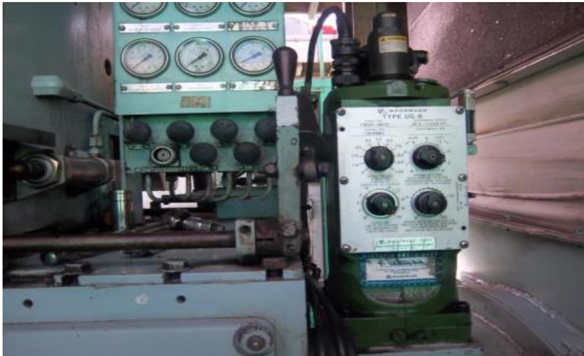
Anexo. 11 Regulador del indice de inyección (Gobernador).
