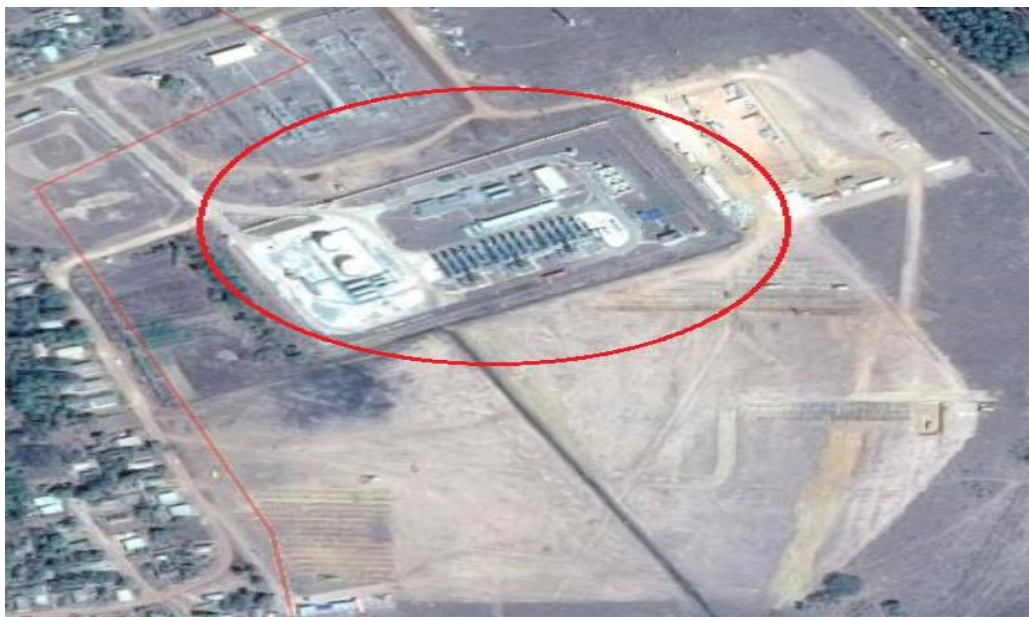
Figura 1.1 Ubicación real de la Central Eléctrica Fuel-Oil Yaguaramas.
