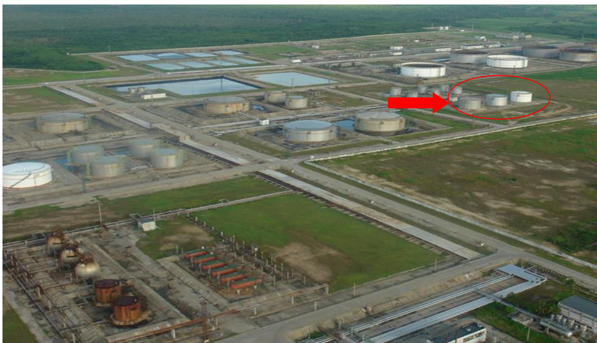
Anexo 8 Tanques de 5000m 3 de TK 25
