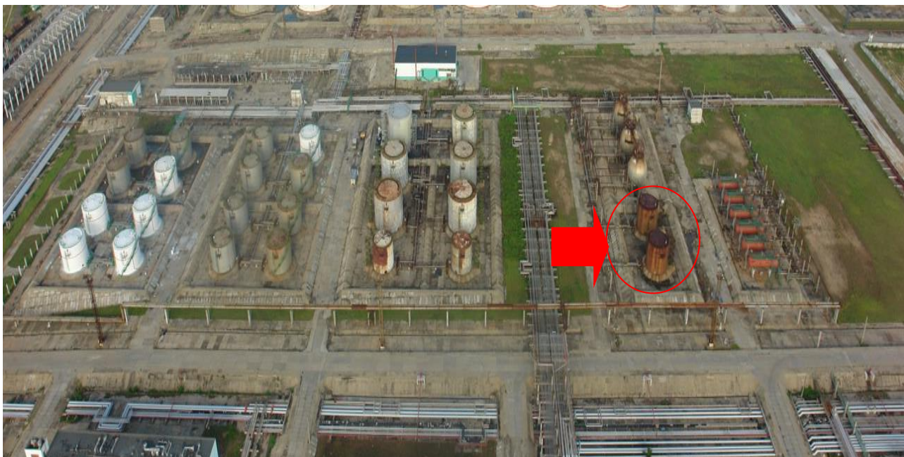
Anexo 2 Depósitos de 700 m 3 de TK 40
