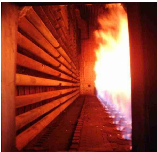
**Figura 1.4:** Sección de radiación de un horno de proceso. **Fuente:** (EENTERM.ca PDVSA. 2008)
