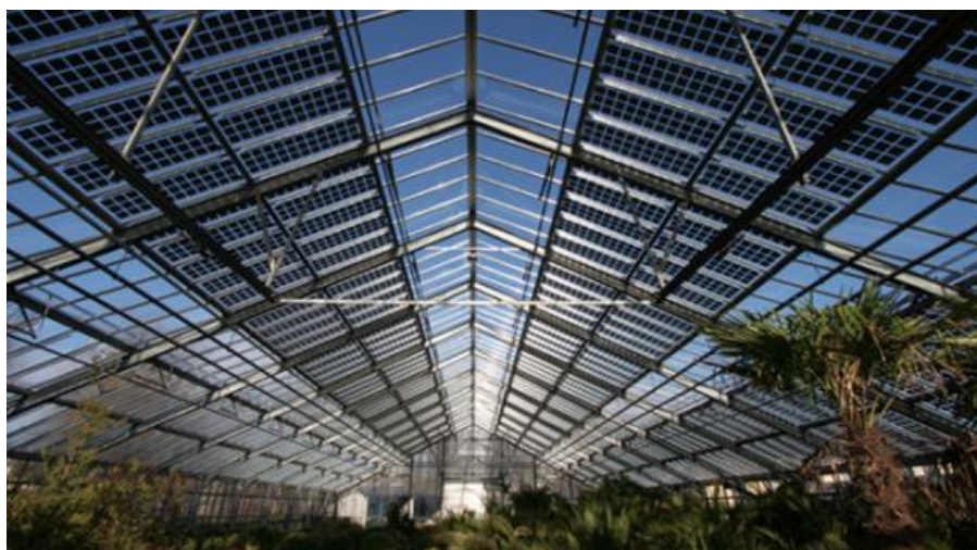
Figura 1.14. El Palmenhouse Munich, Alemania. (Wiki Arquitectura, 2018)
