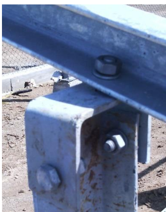
Figura 3.13. Tornillos empleados para la sujeción de la mesa.
