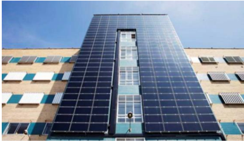
Figura 1.12. Hospital de Granada, España. (Solartex, 2018)
