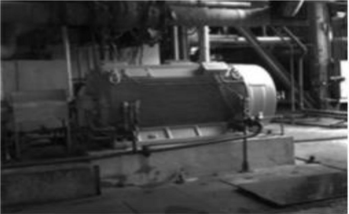
**(Anexo E) Imagen del motor eléctrico de la bomba de agua de alimentar calderas**
